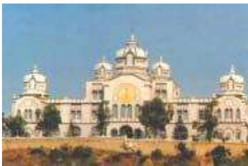
Bâtiment administratif, Université Srī Sathya Sai.
